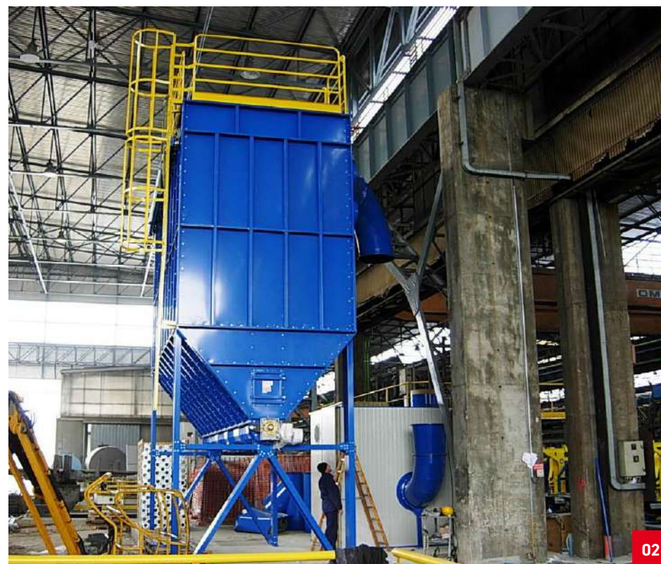
02. Filtro di abbattimento polveri di troncatura metalli. Filter for steel cutting dusts. Фильтр для улавливания пыли, образующейся при обрубке металлов.
